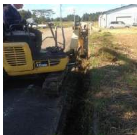
側溝泥上げ・補修
