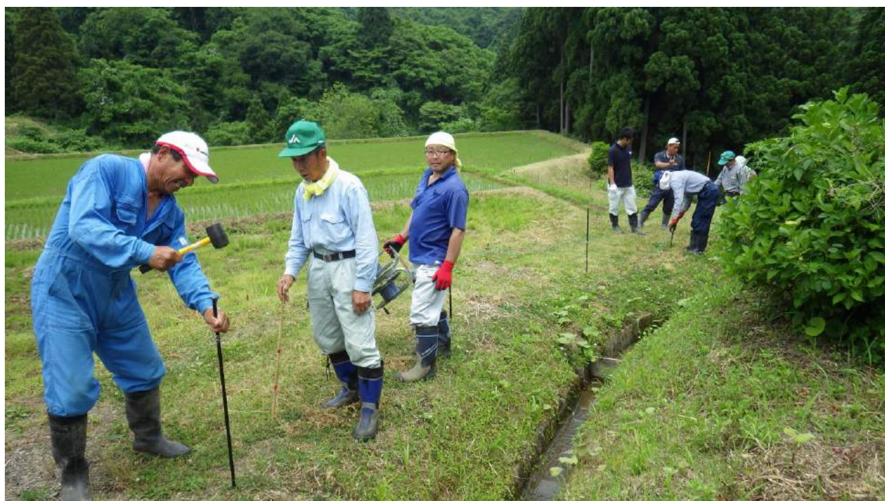
電気柵の設置作業
