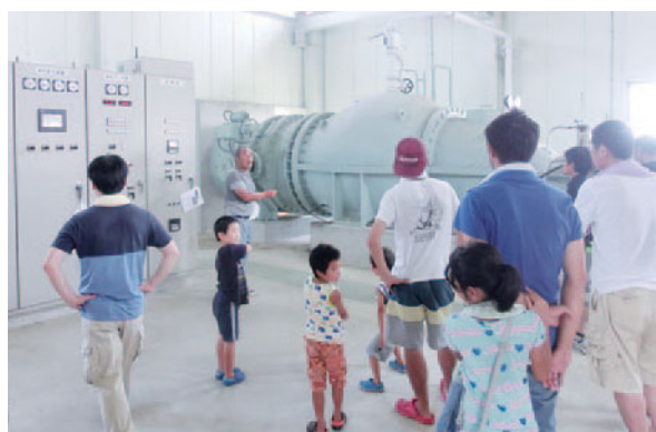
第二八田排水機場を見学
