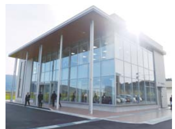
土地改良区事務所
