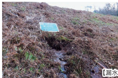
【現地点検調査】
